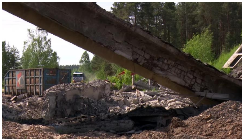
Neretas ielas vecā gaisa tilta demontāža
