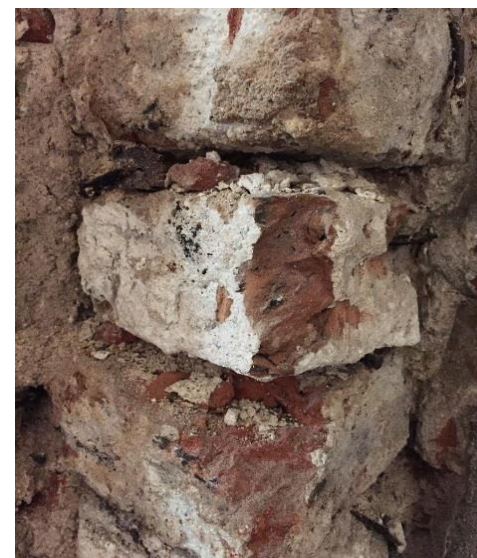
Mūra šuvju javas erozija virs 4 cm
