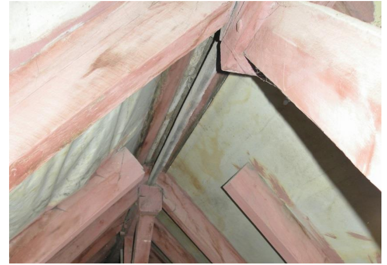
Mehāniski bojāts koptura posms
