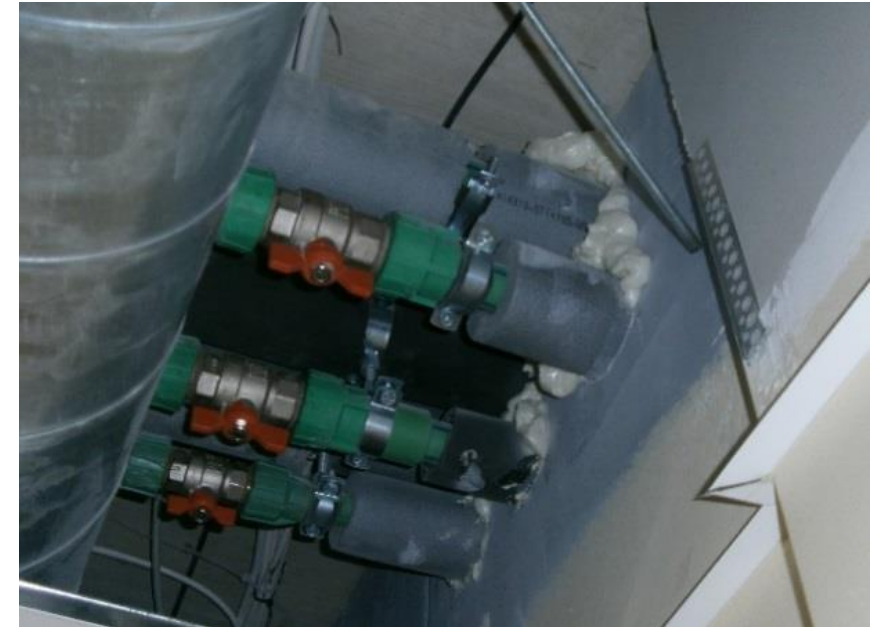
Komunikāciju šķērsojumi aizdarīti ar viegli uzliesmojošiem materiāliem.
