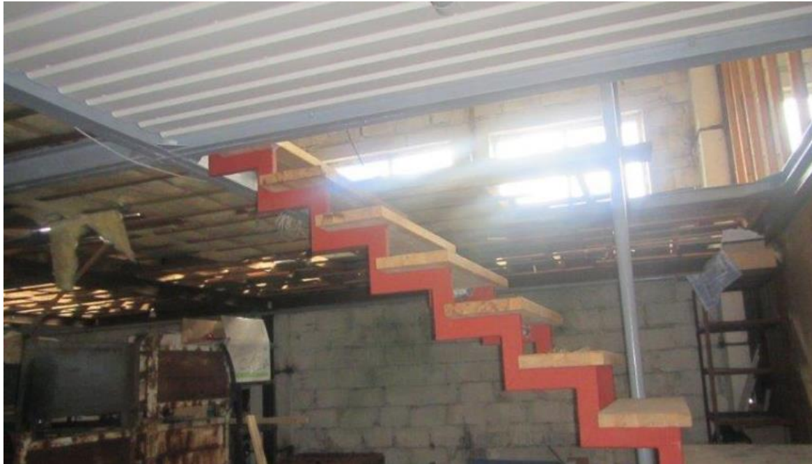
Ēkas daļā izbūvēts 2.stāvs
