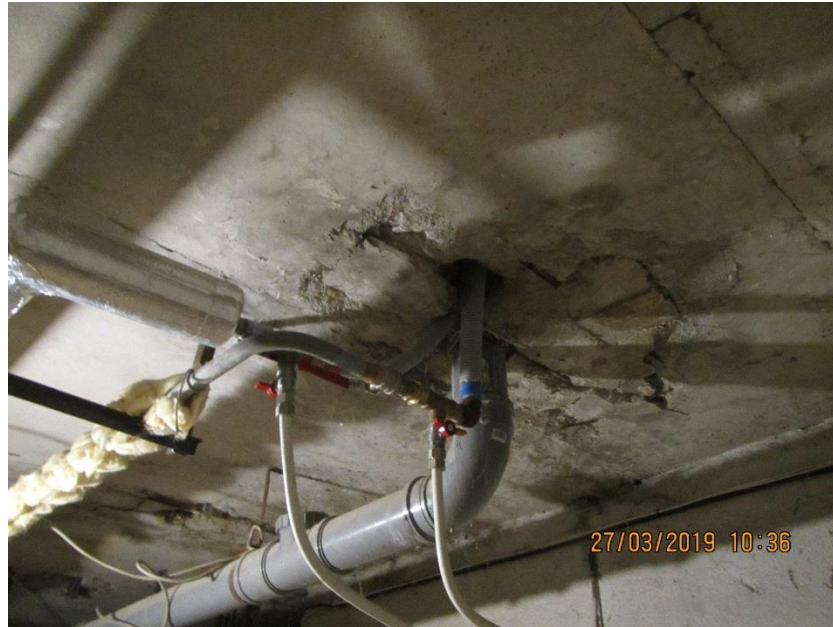
Komunikāciju šķērsojums nav atbilstoši aizdarīts un noblīvēts.
