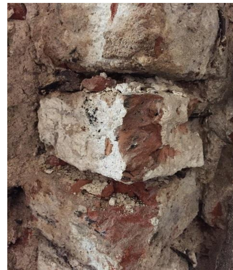
Mūra šuvju javas erozija virs 4 cm
