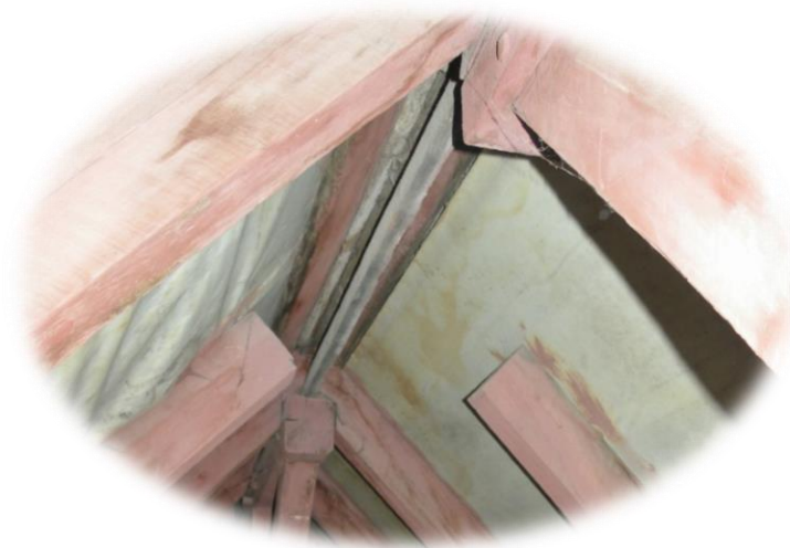
Mehāniski bojāts koptura posms
