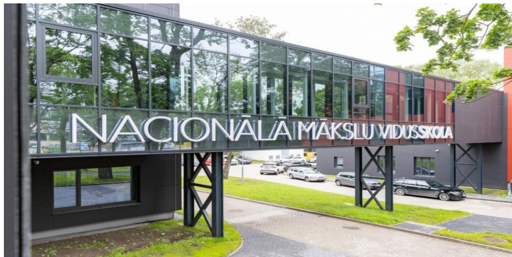
Jaņa Rozentāla Mākslas skolas ēka Slokas ielā 52A, Rīga
