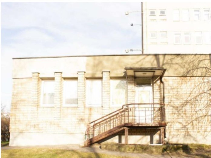
ĀRĒJĀS KĀPNES IEKĻAUTAS KADASTRĀLĀS UZMĒRĪŠANAS LIETĀ UN IESKAITĪTAS ĒKAS APBŪVES LAUKUMĀ
