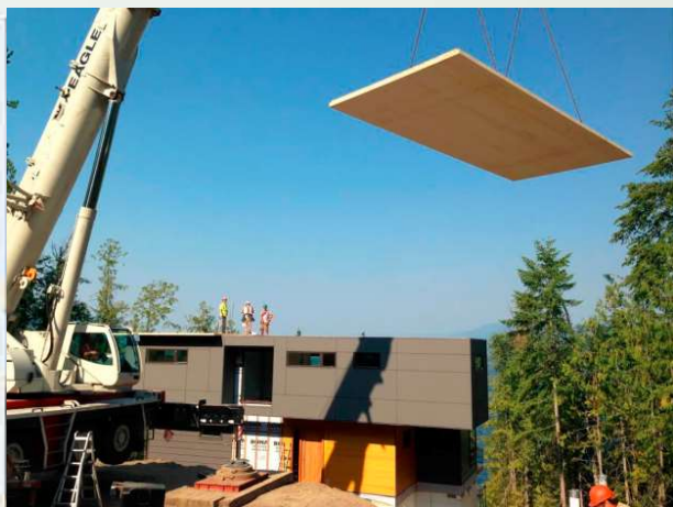
Jumta elementu montāža
