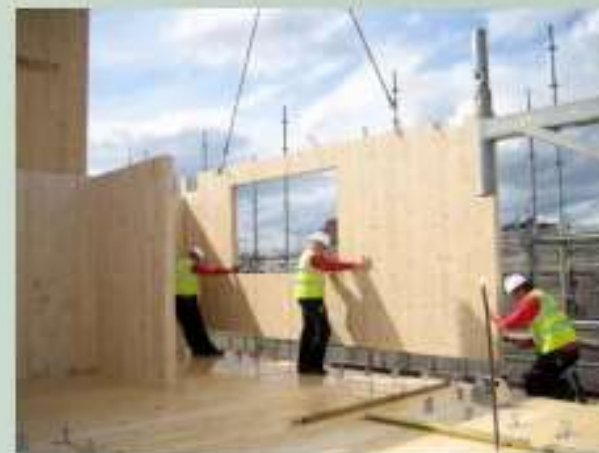
Sienu elementu montāža
