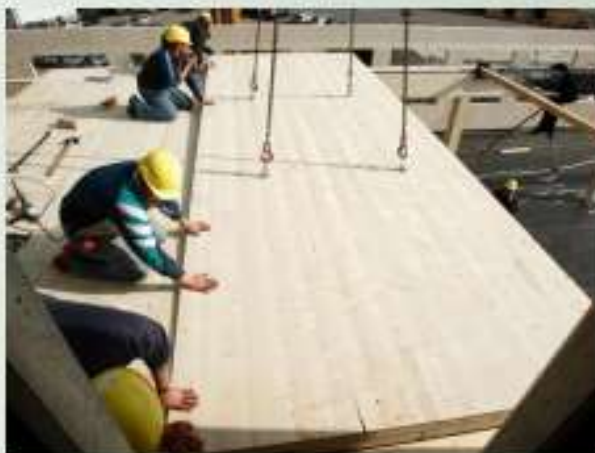
Pārseguma elementu montāža
