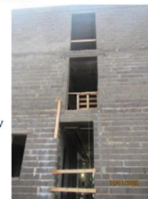
Mūrēšanas darbi 2.stāvā ir veikti neatbilstoši ražotāja instrukcijai.
