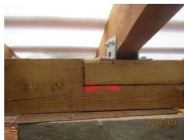
Koptura savienojums virs balsta. Šāds koptura stiprinājuma mezgls būvprojektā nav paredzēts
