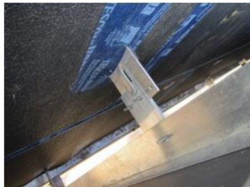
Instrukcijai neatbilstoši stiprinājumu pagarinājumi.
