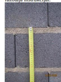
Šuvju biezums mērījumu vietā 20mm un 30mm.
