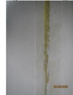
Netiek izmantoti stūra pielaiduma profili izlīdzinoties ar sieta armējumu
