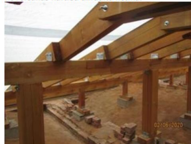
Koptura savienojums zem spāres ir veikts neatbilstoši būvprojektam (savienojuma vieta
