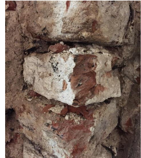
Mūra šuvju javas erozija virs 4 cm
