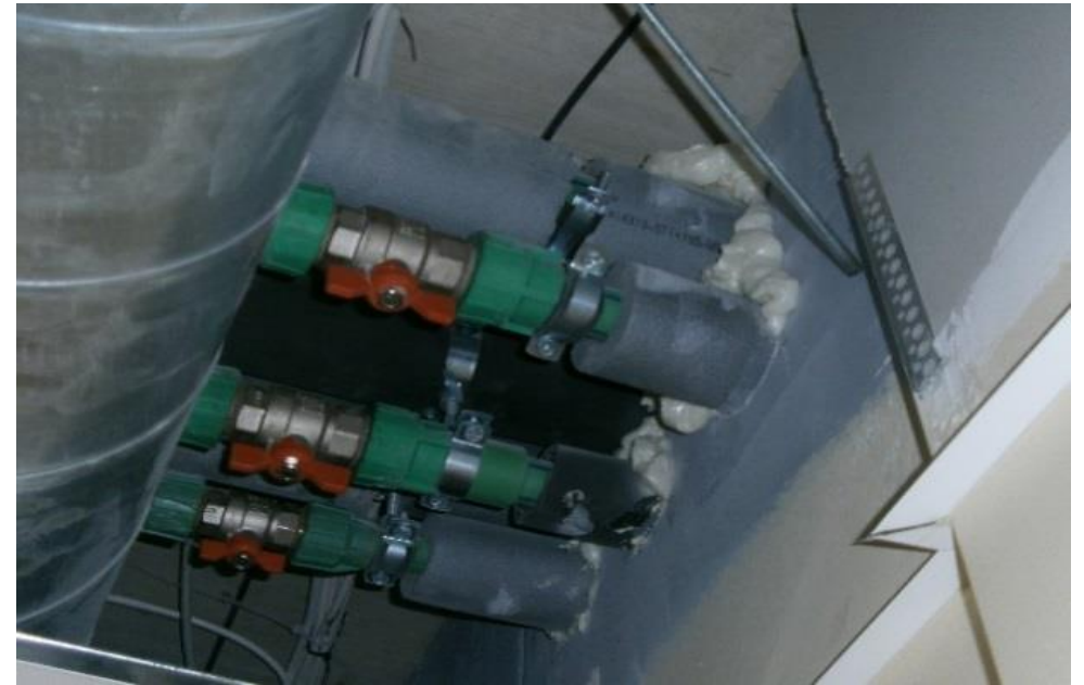
Komunikāciju šķērsojumi aizdarīti ar viegli uzliesmojošiem materiāliem.
