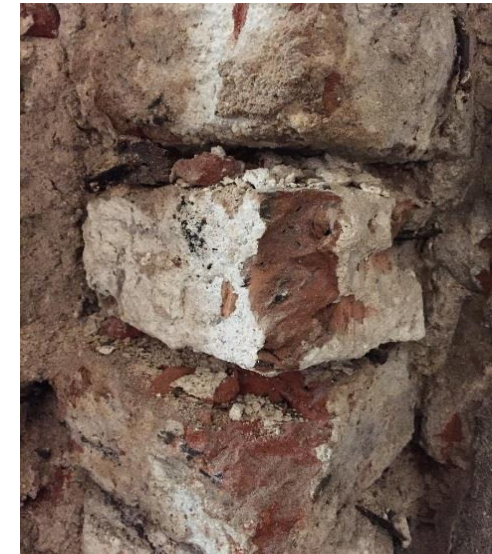
Mūra šuvju javas erozija virs 4 cm
